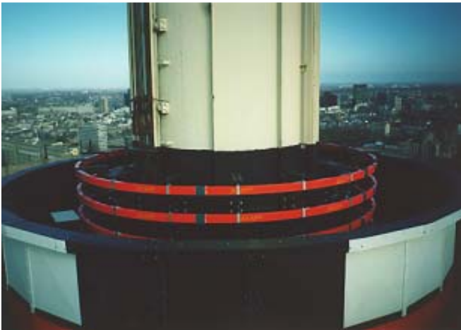
četiri kružna voda za napajanje rotirajućeg lifta
