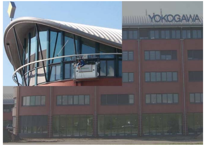
napojni vod sa lučnim segmentima postrojenja za čišćenje fasade
